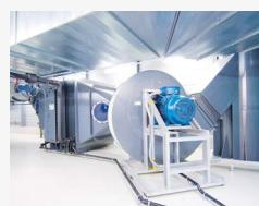
Ventilateurs en plastique pour le transport efficace et sûr de l'air vicé et des gaz corrosifs
