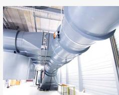
Installations de ventilation en plastique pour une évacuation efficace de l'air vicé et des gaz corrosifs
