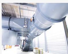
Lüftungsanlagen in Kunststoff für die effiziente Weiterleitung korrosiver Abluft und Gase
