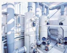
Abluftreinigungsanlagen in Kunststoff zur Behandlung umweltschädlicher Abluft und Gase
