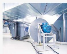
Ventilateurs en plastique pour le transport efficace et sûr de l'air vicé et des gaz corrosifs
