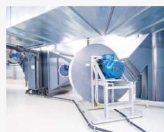
Kunststoffventilatoren für die effiziente und sichere Förderung korrosiver Abluft und Gase
