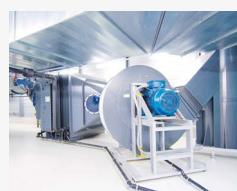
Ventilateurs en plastique pour le transport efficace et sûr de l'air vicié et des gaz corrosifs
