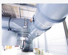
Lüftungsanlagen in Kunststoff für die effiziente Weiterleitung korrosiver Abluft und Gase
