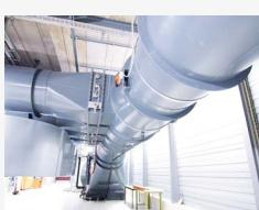
Installations de ventilation en plastique pour une évacuation efficace de l'air vicié et des gaz corrosifs
